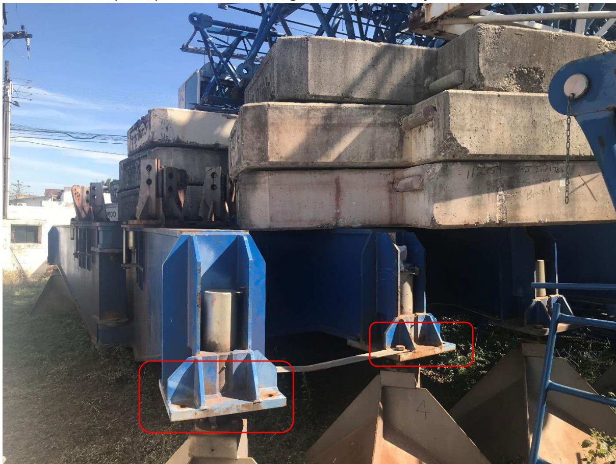
Faltando todos os pinos, plataformas, escadas, guarda corpos de 6 seção de torre D33
